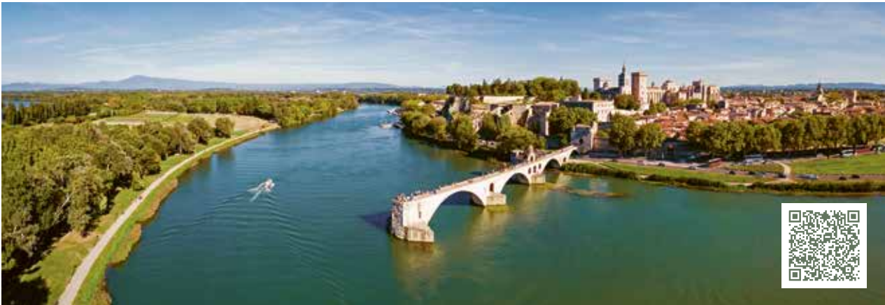
SAINT-BÉNÉZET BRIDGE, AVIGNON
